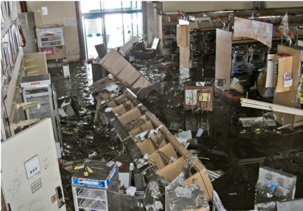
矢本店の店内ではカウンターが倒壊した
